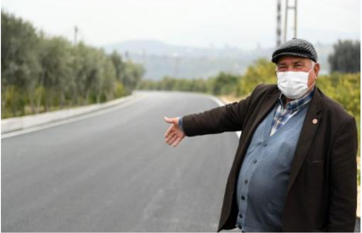
ELVANLIDAKİ GRUP YOLUNDA 1600 METRELİK SICAK ASFALT
